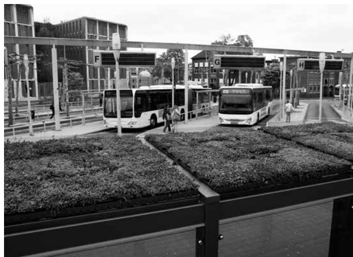
Groen dak op een abri van busstation Apeldoorn
